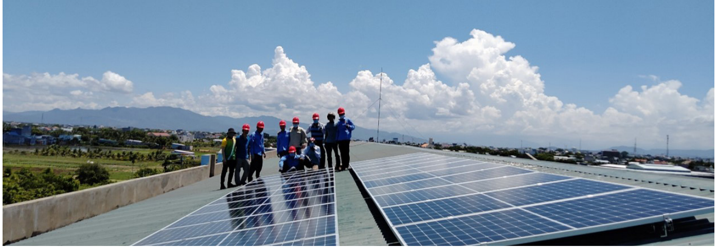
Các giáo viên trường Cao đẳng nghề Ninh Thuận lắp đặt hệ thống điện mặt trời áp mái nối lưới 10 kwp trong một buổi đào tạo thực tế.
