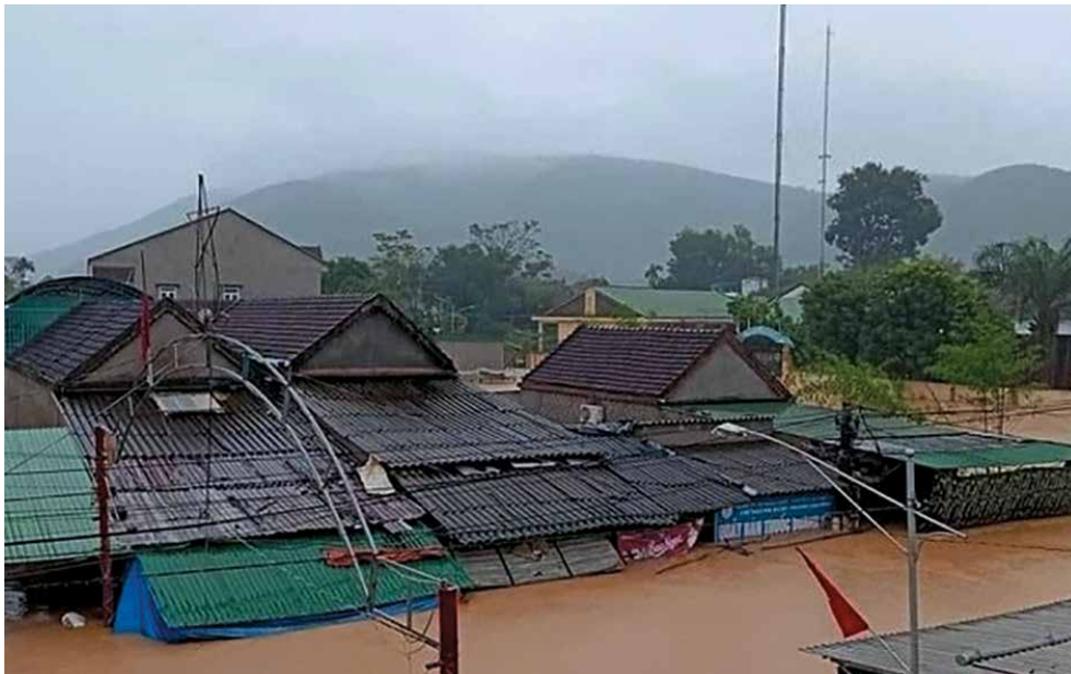
Hình 1.33: Một trường hợp bị ngập úng do nhà máy thủy điện xả lũ
