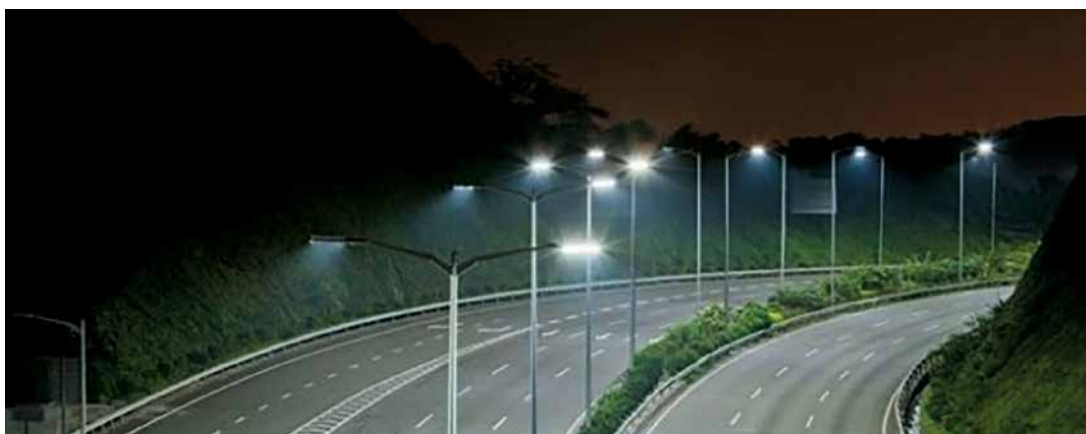
Hình 1.40: Ứng dụng công nghệ chiếu sáng LED cho các dự án giao thông
