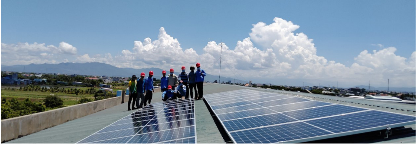
Các giáo viên trường Cao đẳng nghề Ninh Thuận lắp đặt hệ thống điện mặt trời áp mái nổi lưới 10 kwp trong một buổi đào tạo thực tế.
